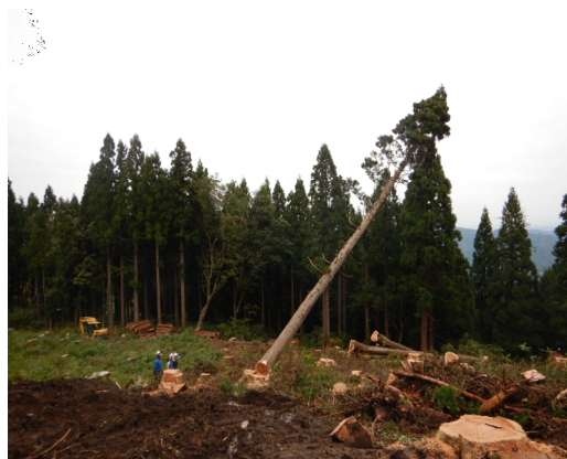
伐採中の写真
