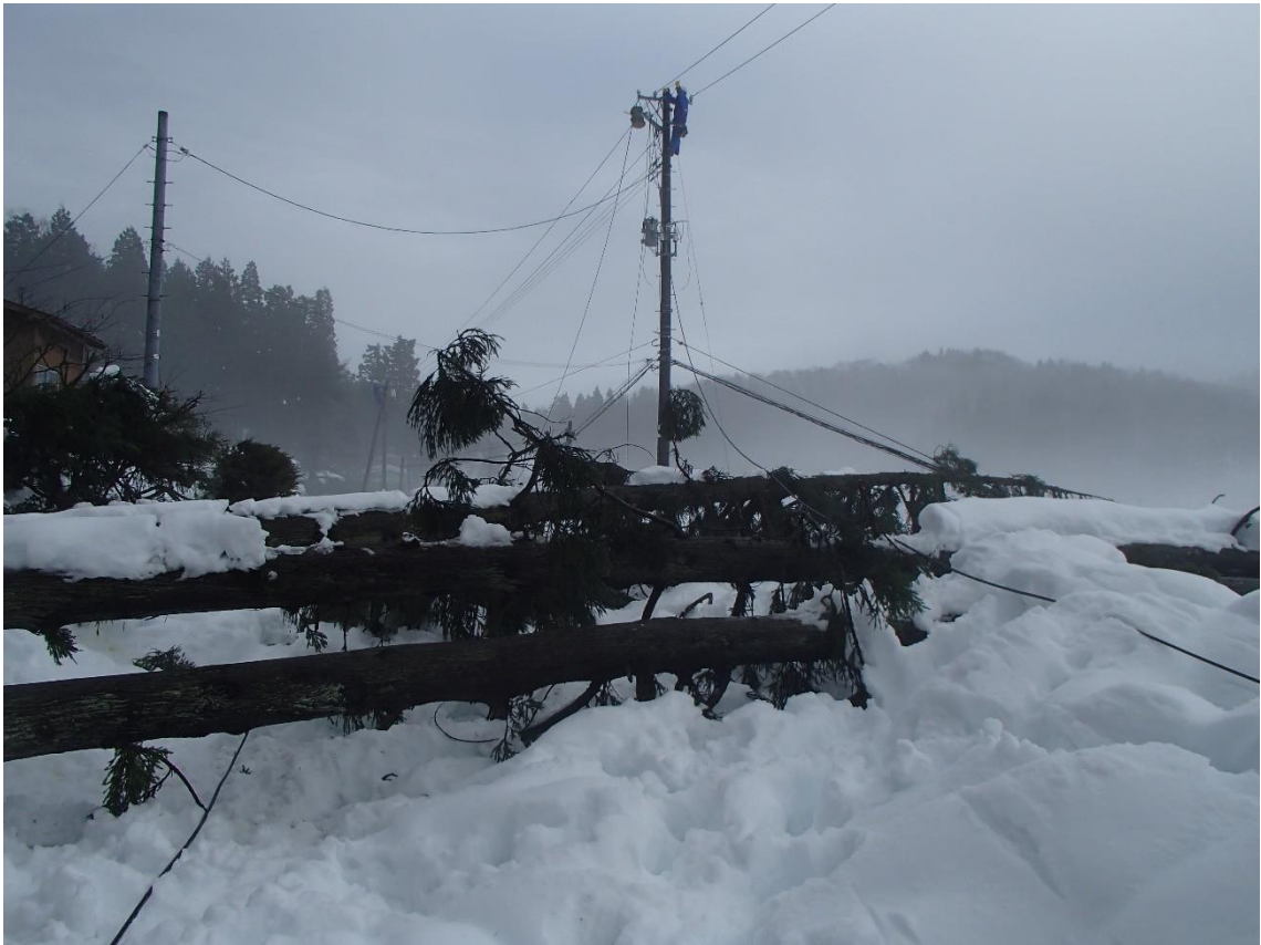
⑤ 倒木により断線した電線（旧広田地内）
