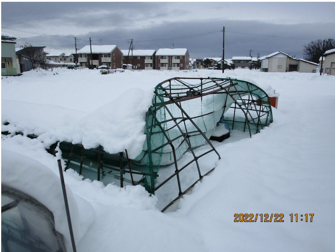
⑧ 大雪により損壊した農業用ビニールハウス（岩上地内）
