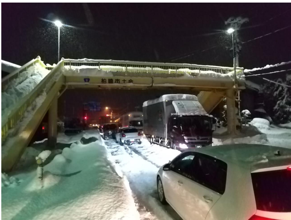
① 立ち往生している国道8号の状況（土合地内）
