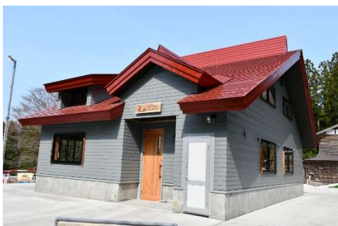
完成した休憩施設
