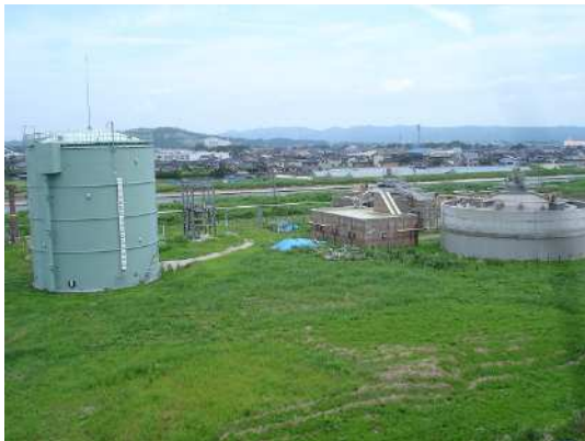
写真5 . 自然環境浄化センター 【消化タンク】
