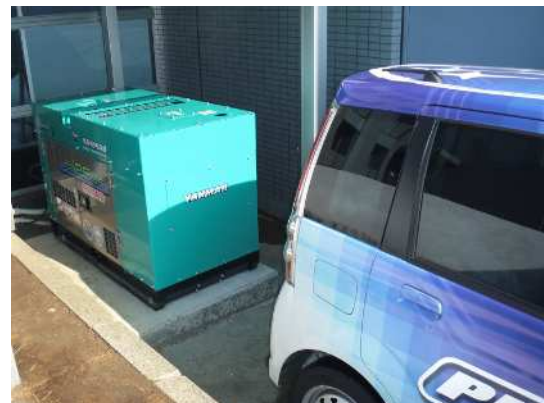
写真8 . 新潟工科大学 【左：バイオディーゼル発電機】 【右：電気自動車】
