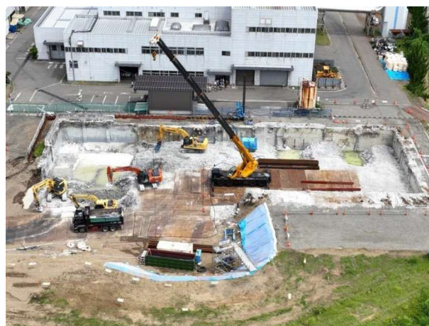
し尿処理施設解体状況
