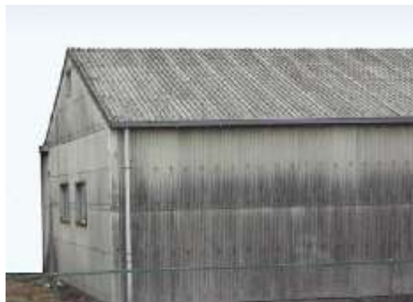
石綿含有スレート波板（屋根・外壁）
