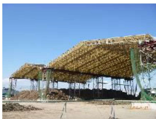
可燃物の貯留ヤード
