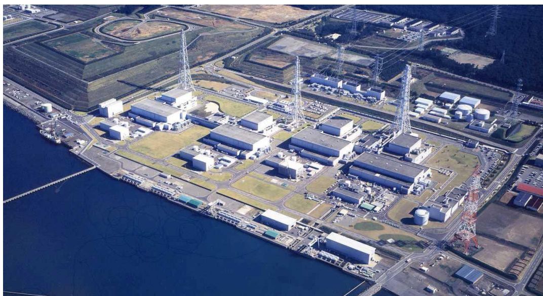
4 号機 3 号機 2 号機 1 号機
