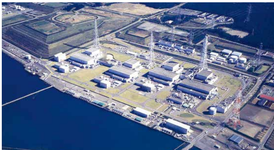
4 号機 3 号機 2 号機 1 号機
