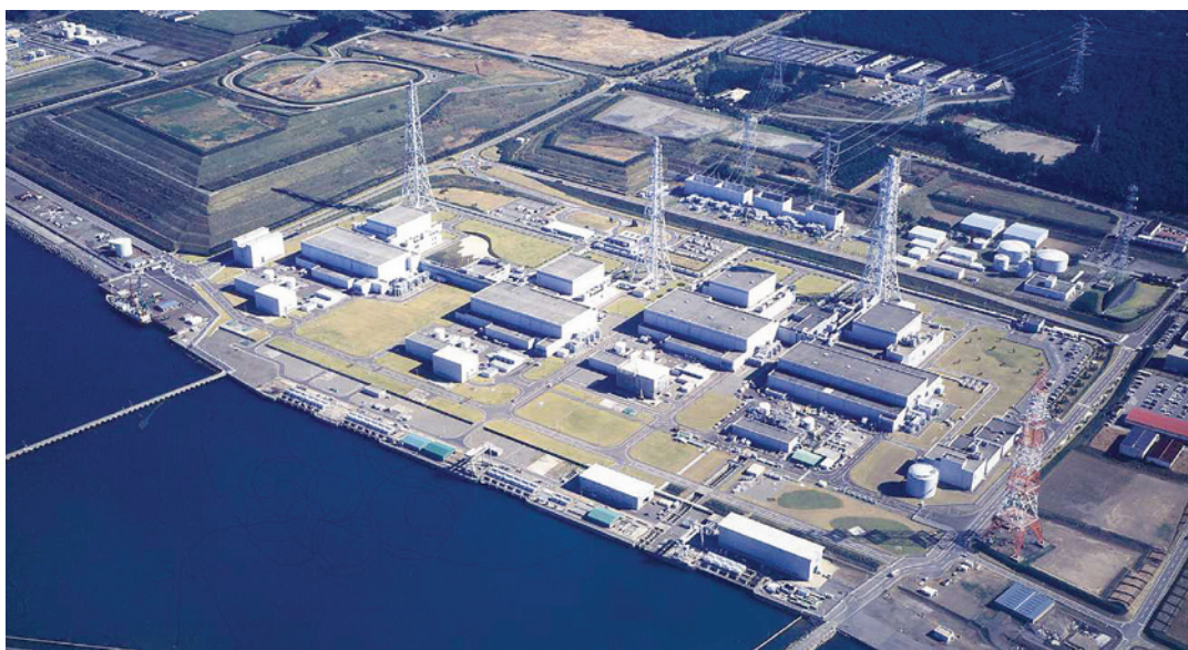
4号機 3号機 2号機 1号機
