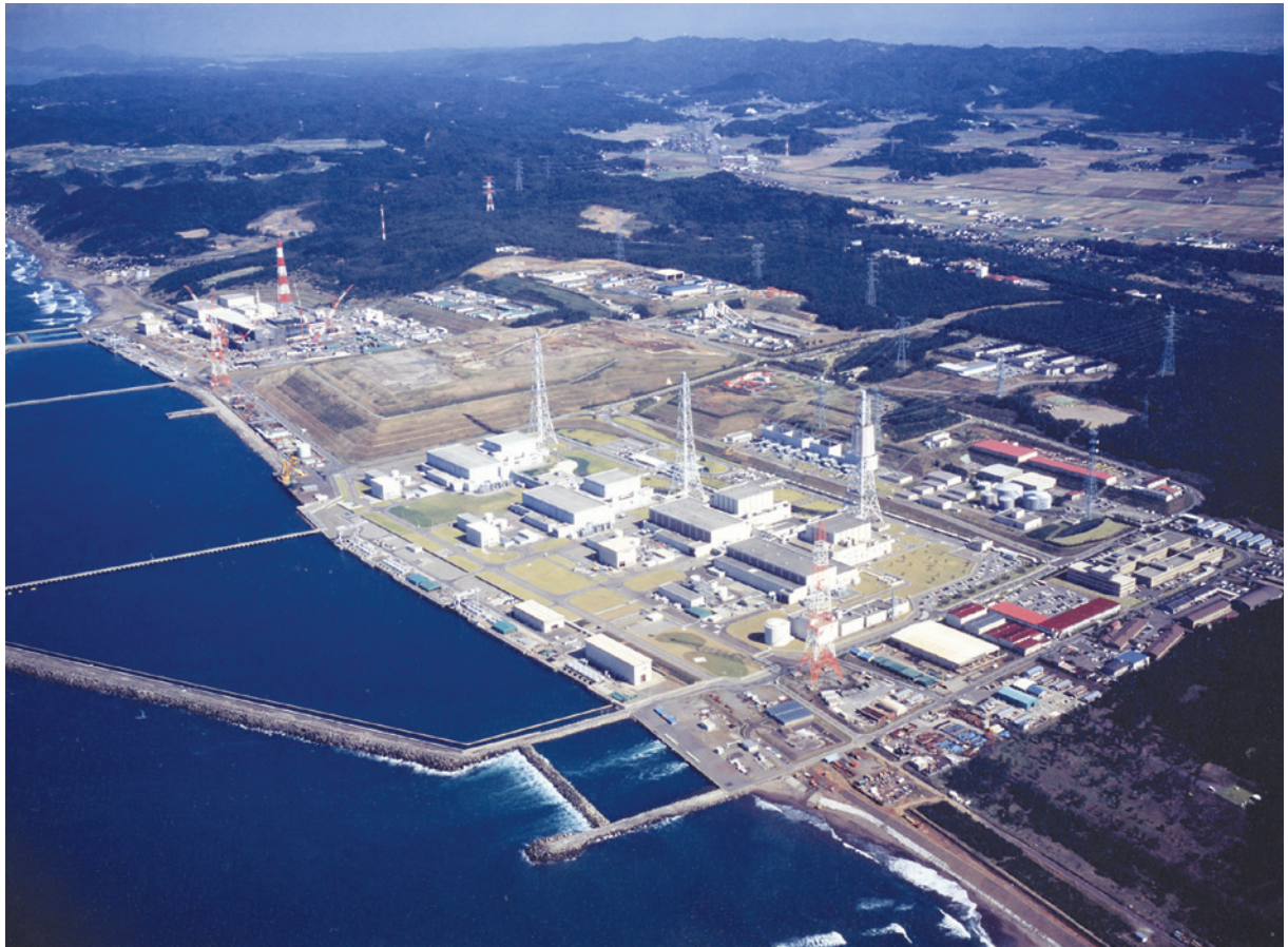
平成 7 (1995) 年当時の柏崎刈羽原子力発電所
