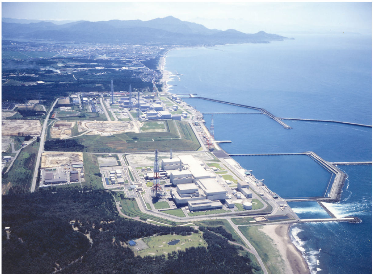
平成 14 (2002) 年当時の柏崎刈羽原子力発電所
