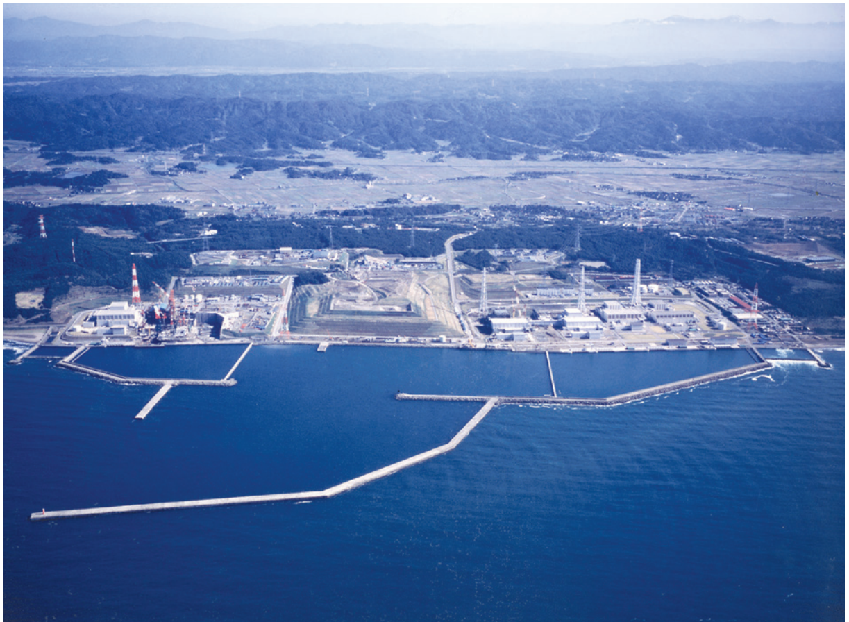
平成 4 (1992) 年当時の柏崎刈羽原子力発電所
