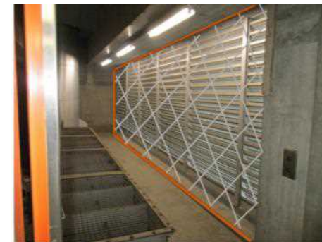
竜巻防護ネットの設置イメージ
