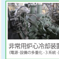
+ 高圧代替注水ポンプ (制御電源不要)
