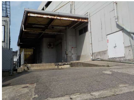
▲搬入口（地下裏側）
