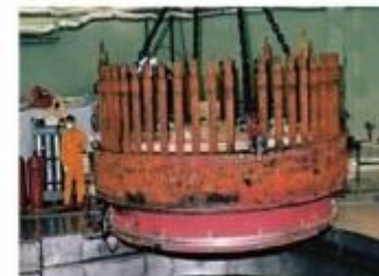
設備解体 (原子力発電所)
