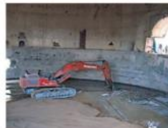
コンクリート除染 (原子力発電所建屋)
