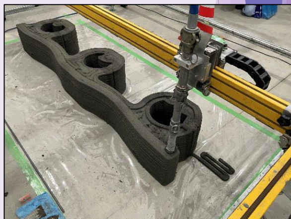
建設用3Dプリンタによる 公園ベンチの製作
