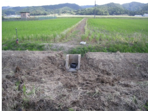
◎大雨時の一時貯留を目的とした 田んぼダムの取り組み
