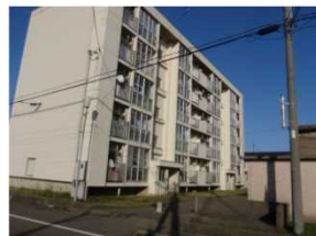
改修対象の棟
