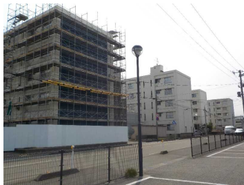
H31.3の施工状況
