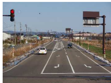
整備が進む国道8号柏崎バイパス
