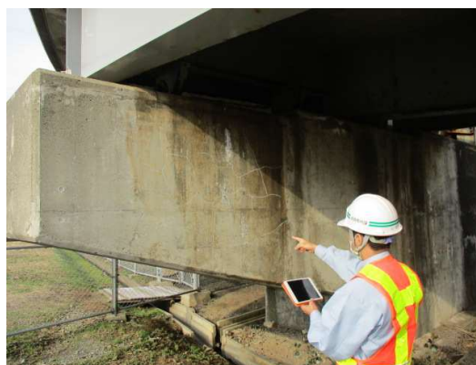
タブレットシステムによる点検
