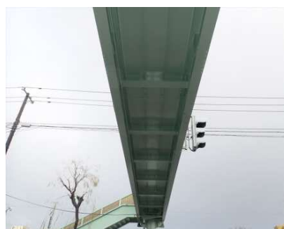
比角小前歩道橋（桁下）
