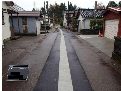
消雪パイプの更新 (メインパイプ)
