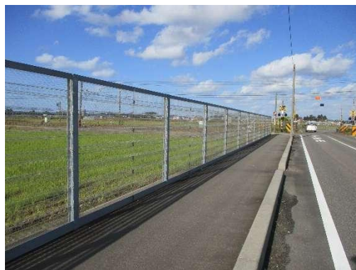
防雪柵設置状況
