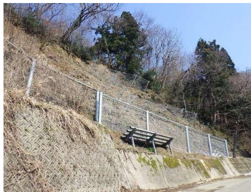
雪崩防止柵設置状況
