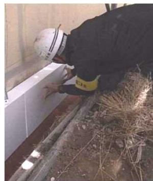
外壁の断熱化工事
