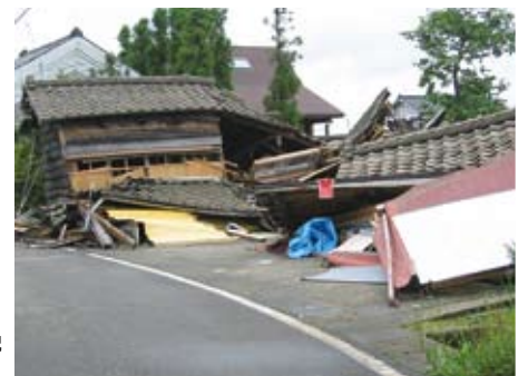
家屋被害の状況 (柏崎市内)
