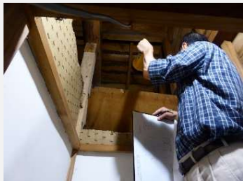
天井裏をチェック
