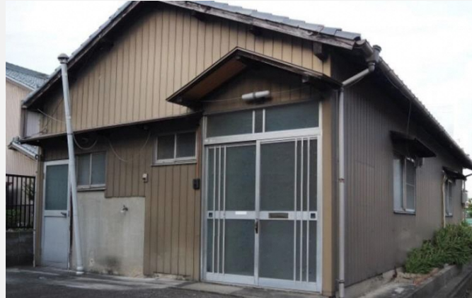
空き家にな ったら
