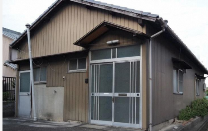
空き家にな ったら
