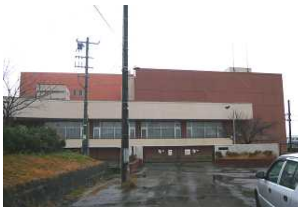
柳橋中継ポンプ場
