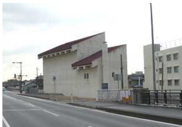
八坂中継ポンプ場
