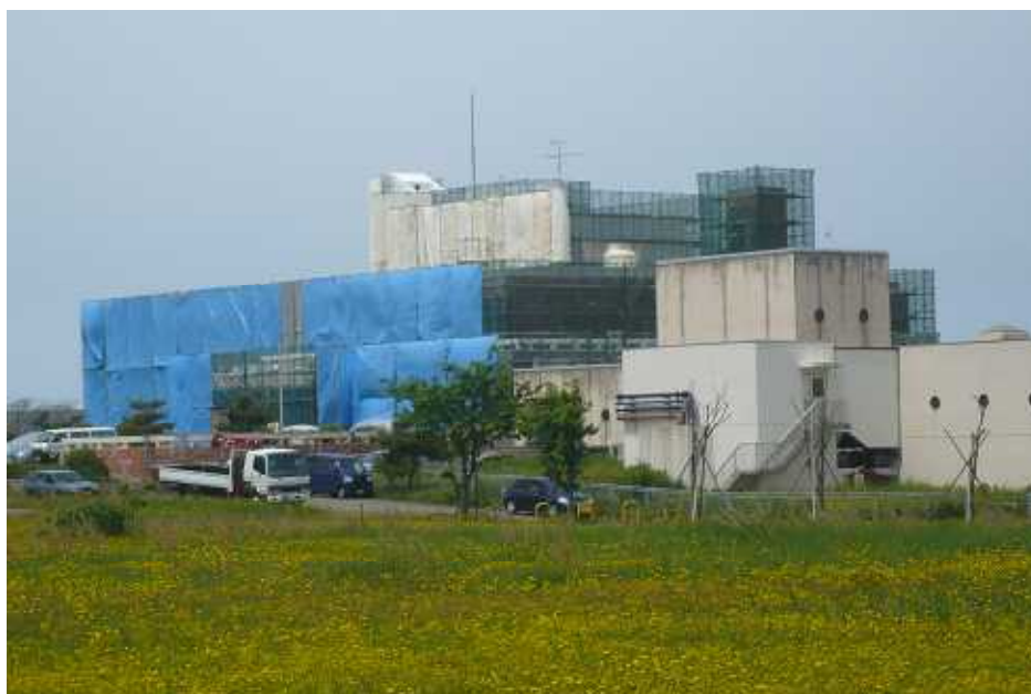
自然環境浄化センター改築更新工事
