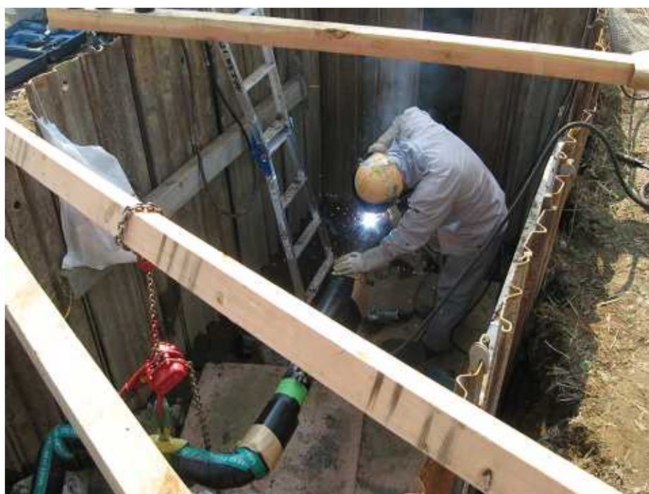
中圧管改良工事
