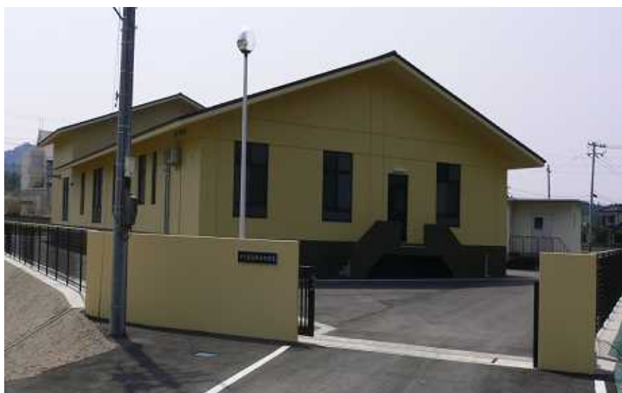
中川集落排水処理場
