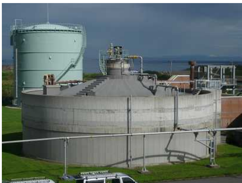
自然環境浄化センター 消化タンクとガスホルダー
