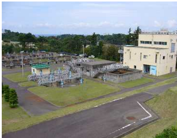
赤坂山浄水場汚泥濃縮棟
