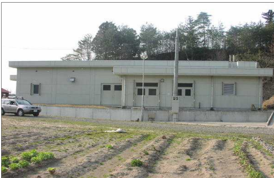
工業用水道 西山町妙法寺浄水場（給水能力400m 3 /日）
