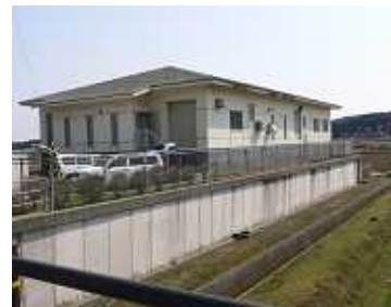
上条集落排水処理場
