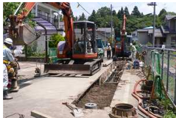
災害復旧施工状況
