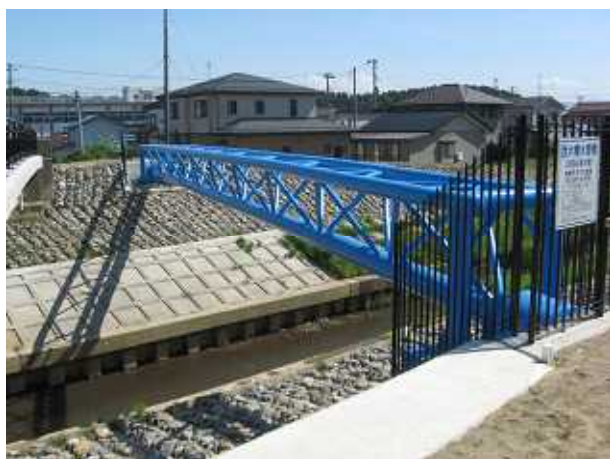
西山給水区域拡張事業 西大橋 350mm トラス式水管橋と西山ポンプ場
