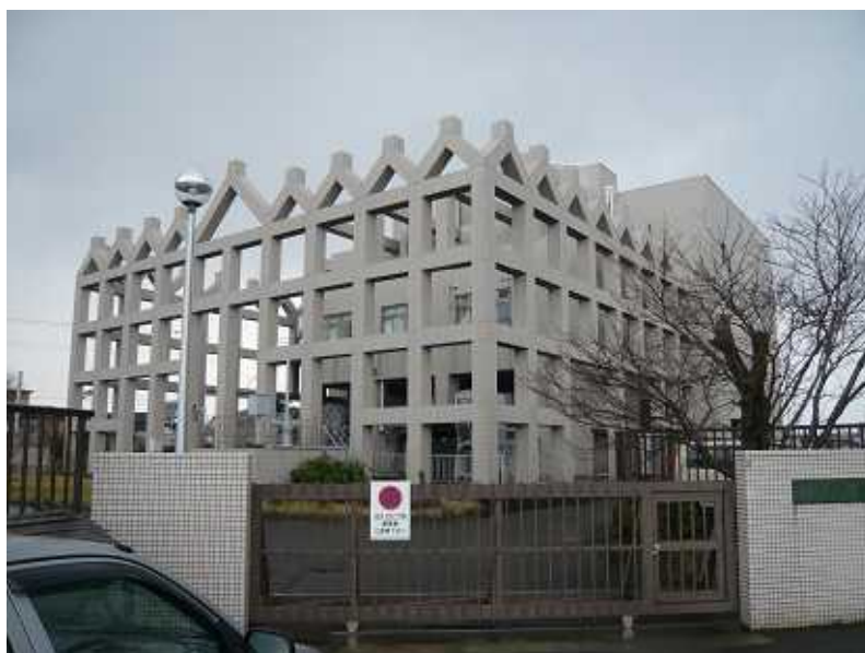
柏崎雨水ポンプ場 (計画流量 22.57m 3 /秒)
