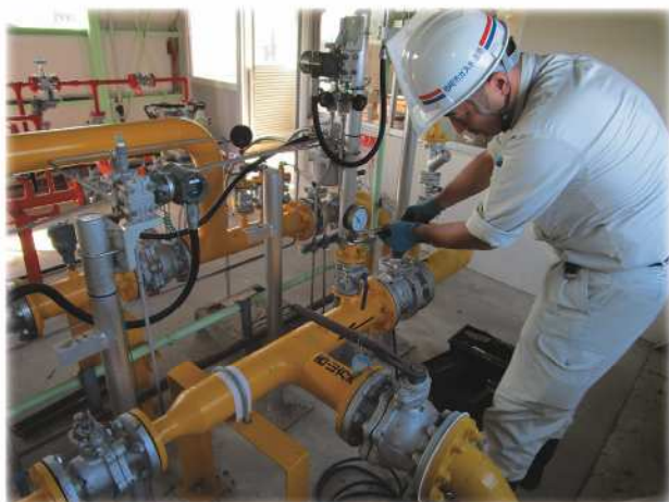
供給所バルブ点検
