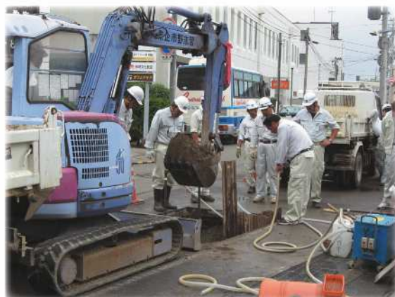
懸命な復旧作業
