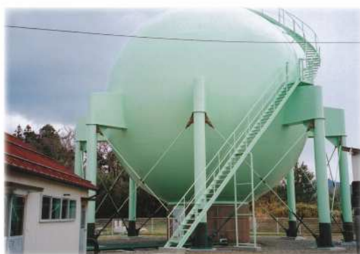
復旧した刈羽ガスホルダーの全景とあるべき場所に戻った支柱
