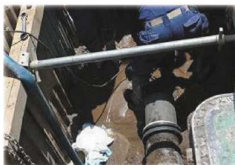
水中ポンプで地下水を汲み上げ
