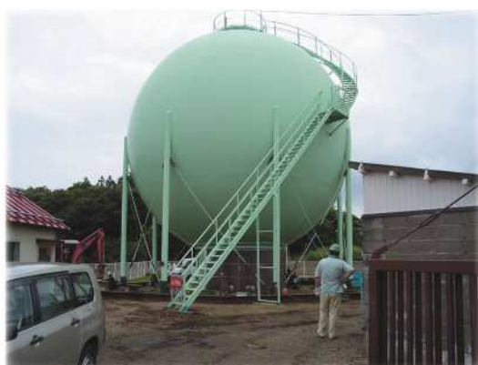
刈羽ガスホルダーの全景とアンカーボルトが破断して横ずれした支柱
