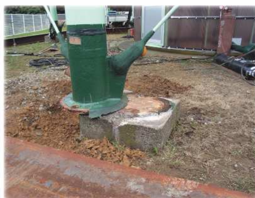
刈羽ガスホルダーの全景とアンカーボルトが破断して横ずれした支柱
