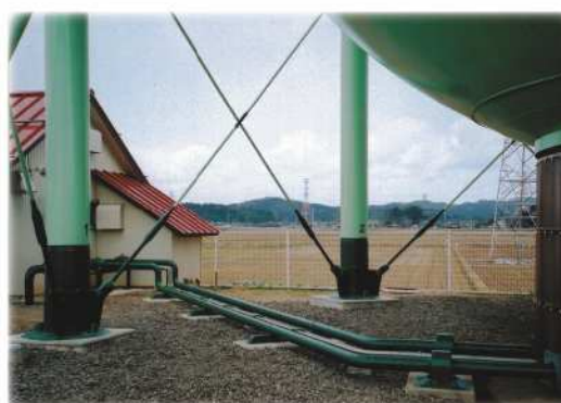
復旧した刈羽ガスホルダーの全景とあるべき場所に戻った支柱
