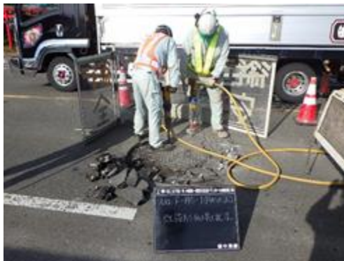
マンホール鉄蓋（更新中）
