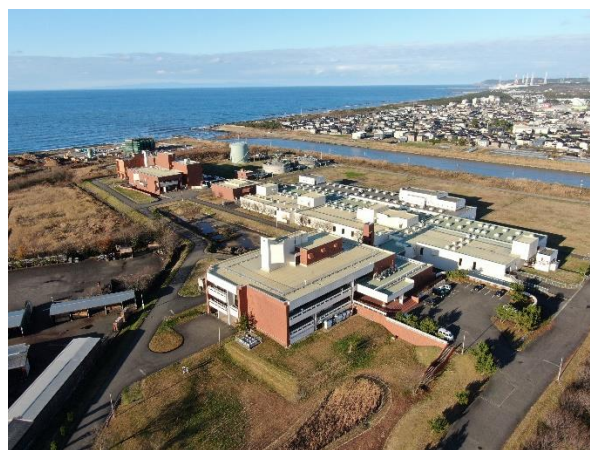
自然環境浄化センター
