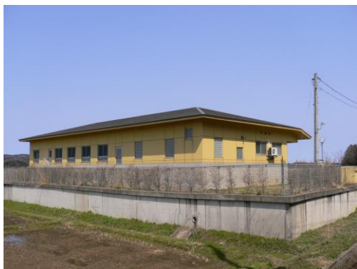
上条東地区処理場 (統廃合・公共下水道への接続検討)
