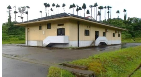
岡田地区処理場
