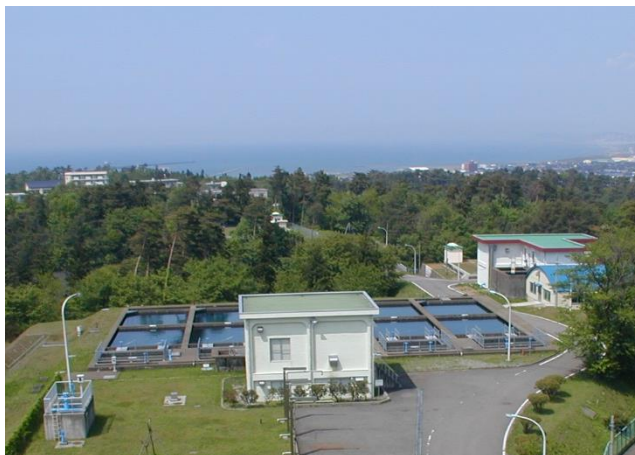
赤坂山浄水場 3・4 拡浄水施設
