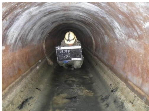
管更生工事（施工前）
