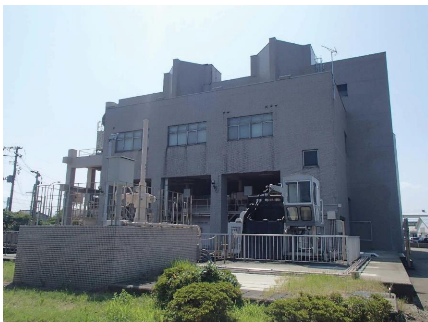
柏崎雨水ポンプ場
