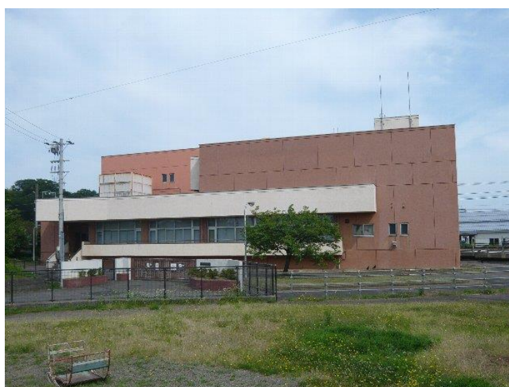
柳橋中継ポンプ場
