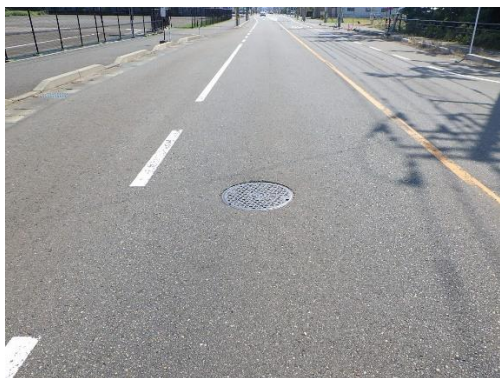
マンホール鉄蓋（更新前）
