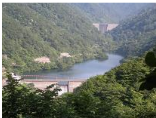
手前：谷根ダム、奥：赤岩ダム
