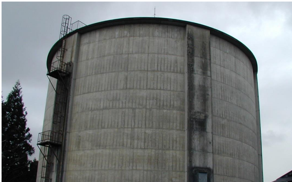
西山P C配水池
