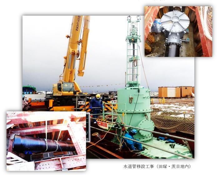
↑水道管 (PN 形鋳鉄管 700mm)
