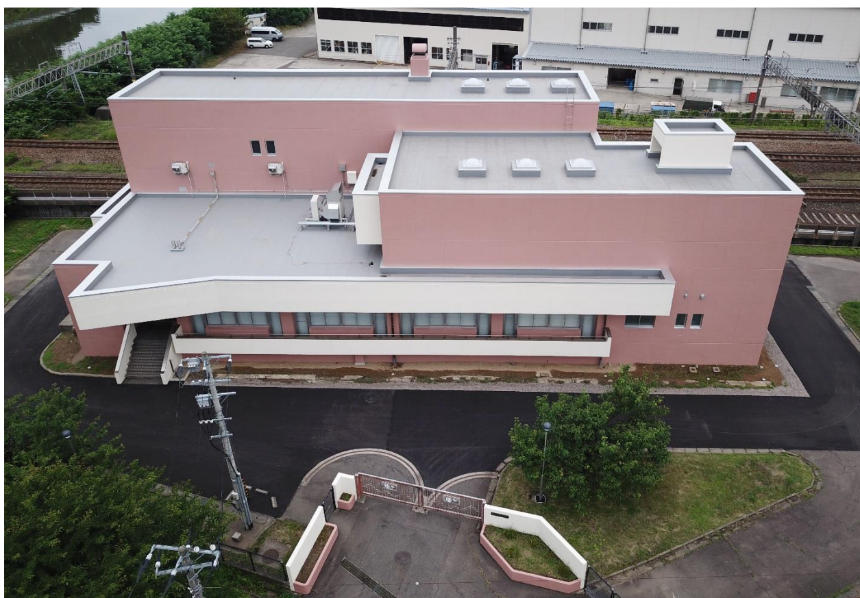
柳橋中継ポンプ場
