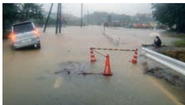
平成17年6月26日半田川氾濫による市道の冠水状況
