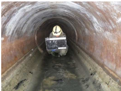
管更生工事(施工前)
