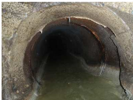
管更生工事（施工前）
