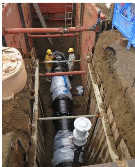
5 拡導水管（φ600mm）耐震化工事
