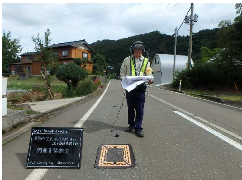
漏水調査（路面音聴調査）
