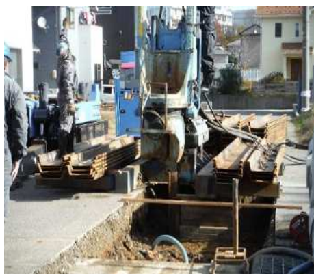
管きょ拡張工事
