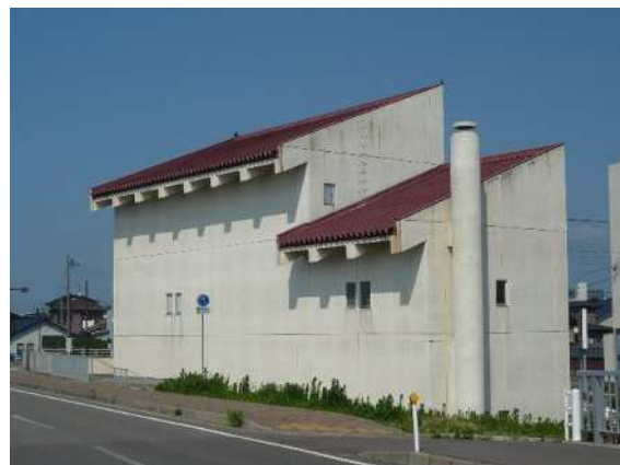
八坂中継ポンプ場
