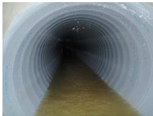
管更生工事（施工後）
