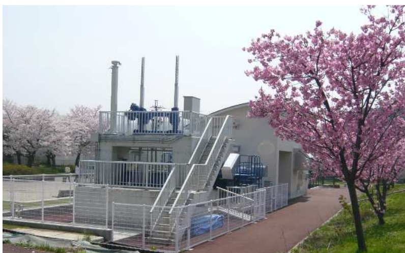
鵜川左岸第 5 雨水ポンプ場（常盤台地内）
