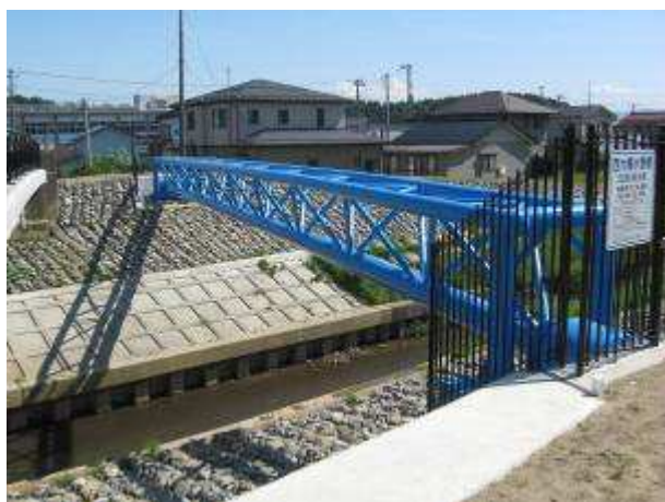
西大橋φ350mm トラス式水管橋と西山ポンプ場
