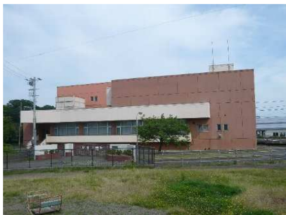
柳橋中継ポンプ場
