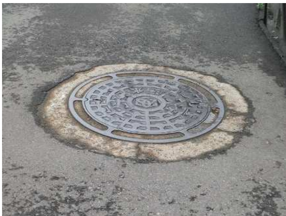
マンホール鉄蓋（更新前）
