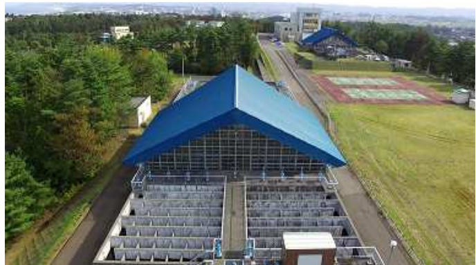
赤坂山浄水場 6 拡浄水プラント
