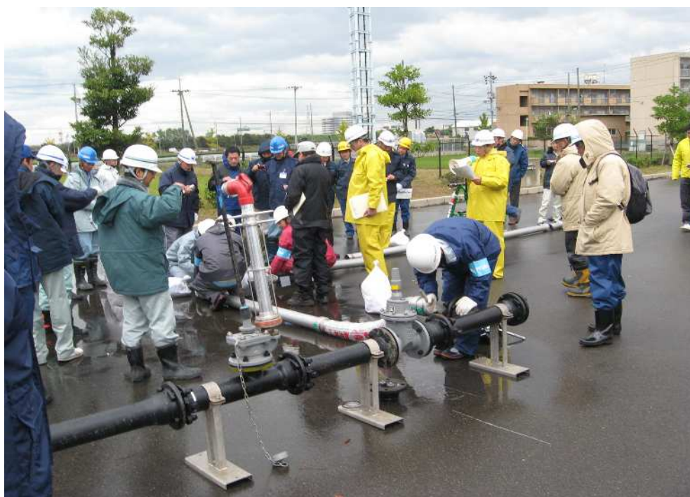
中部支部広域防災訓練状況
