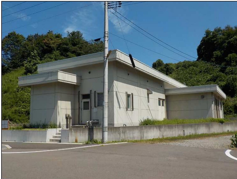
工業用水道 西山町工業用水施設（給水能力 400m 3 /日）
