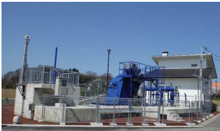
鵜川右岸第 2 雨水ポンプ場（柳橋町地内）
