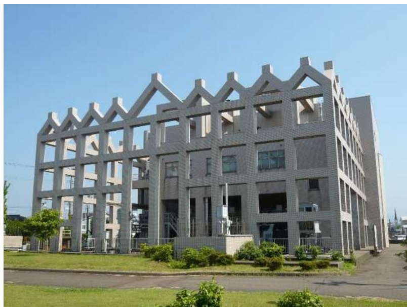
柏崎雨水ポンプ場
