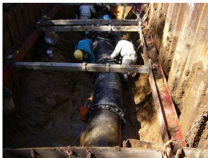
導水管復旧状況
