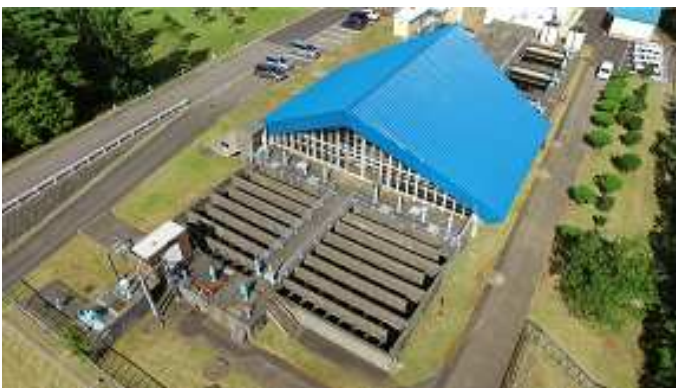
赤坂山浄水場 5 拡浄水プラント
