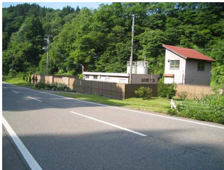
高柳町浄水場
