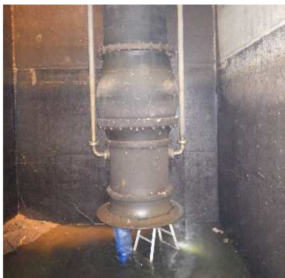
柏崎雨水ポンプ場 No1 雨水ポンプ点検状況
