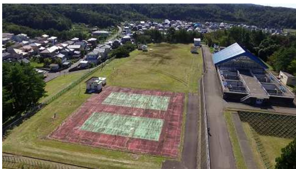
6 拡浄水施設及び 5、6 拡系配水池
