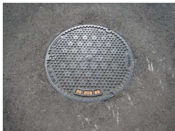
マンホール鉄蓋（更新後）
