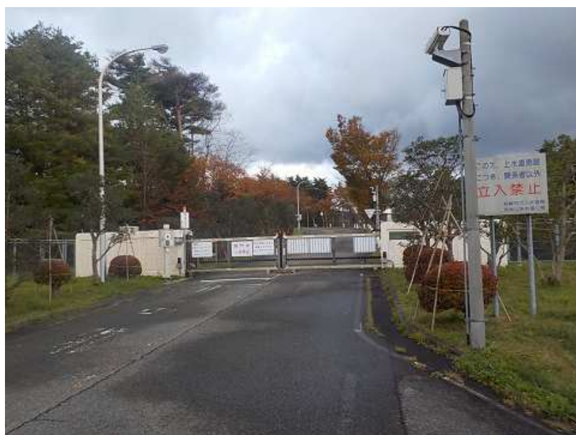
赤坂山浄水場セキュリティーシステム
