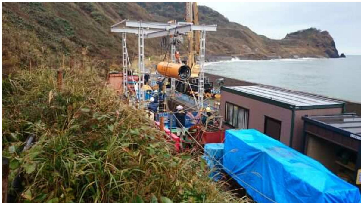
上輪～米山町 推進工事(φ800 mm)施工状況
