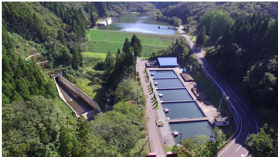
川内ダム・川内浄水場
