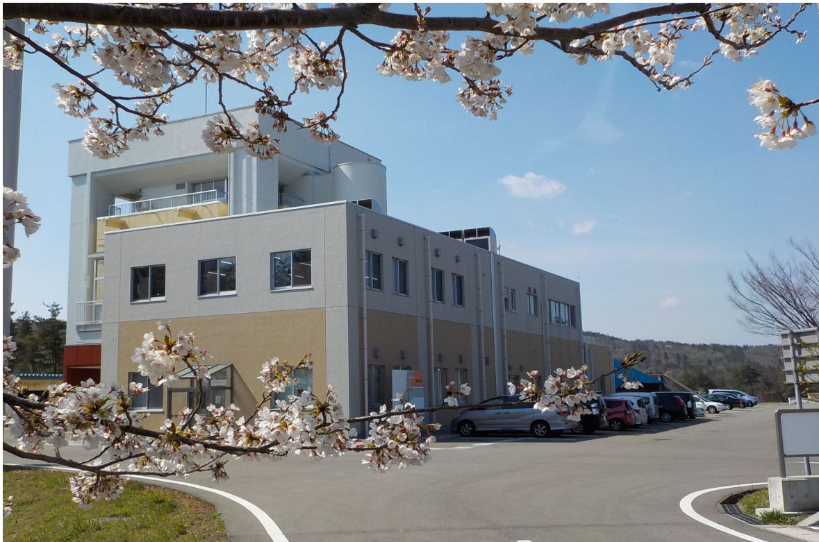
【赤坂山浄水場管理本館】
