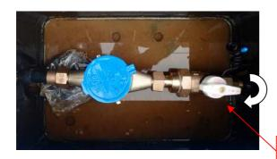
【最近のメーター】 水道メーターボックスを開けると、 メーターとバルブが設置されてい ます。この写真のタイプは右に90 度まわすと水道が止まります。
