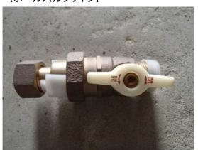
90度まわして開閉するタイプ (水道管内部の水抜き機能なし)
