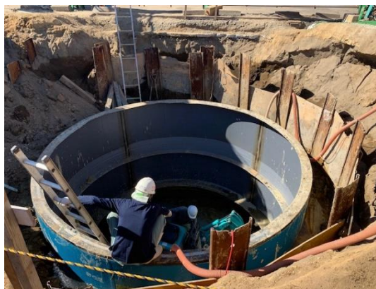
【耐震性防火水槽(40 m 3 )設置工事】
