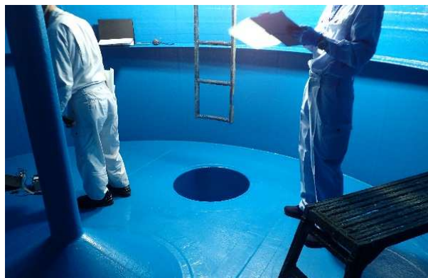
〈防火水槽新設工事検査の現地立会い〉
