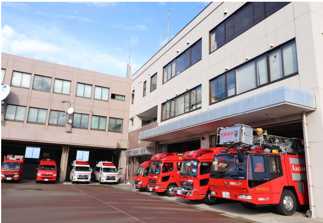
〈消防本部・消防署庁舎〉
