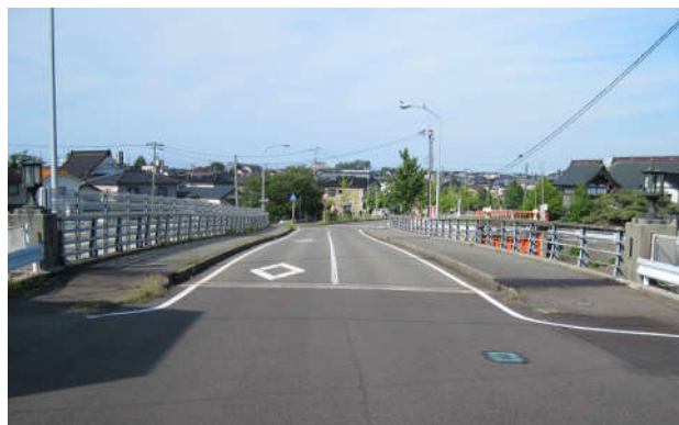
現在の鵜川橋
