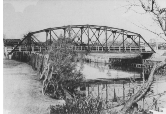
建設初期の水道橋
