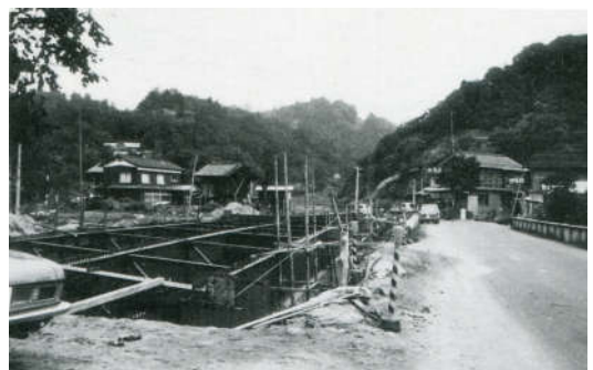
現在の早瀬橋 工事の様子 向かって右が旧早瀬橋 (『たか柳 想懐』(224 タカ) 高柳町編より)
