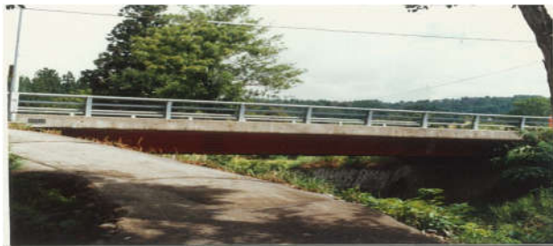
現在の芋川中の橋
