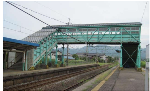
安田駅跨線橋
