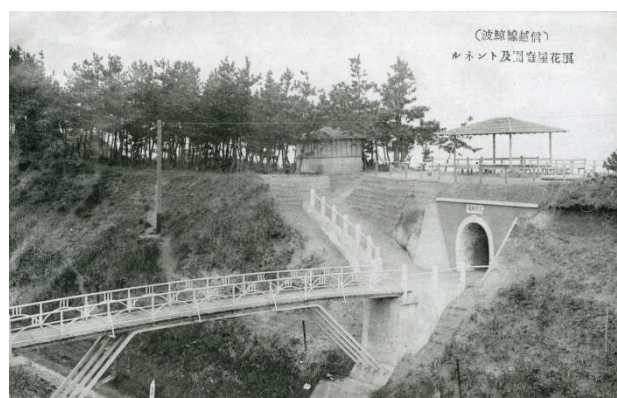
浪花屋旅館の跨線橋
