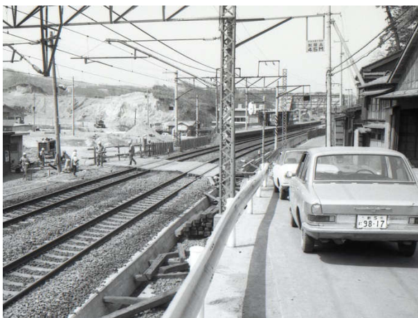
鯨波駅付近の踏切（昭和45年） 広報かしわざき用写真より
