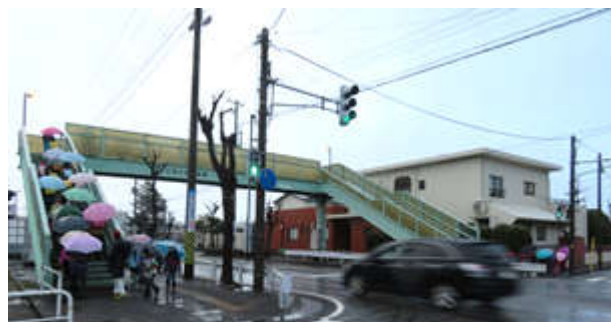
横断歩道橋の様子 右奥に比角小学校がある
