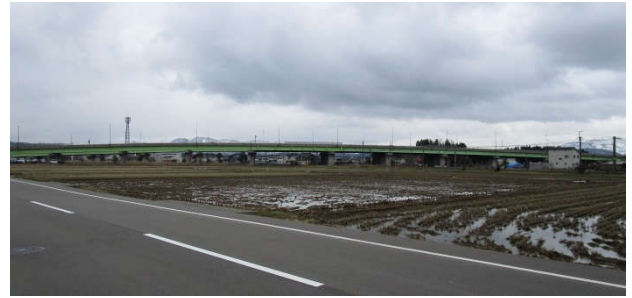
現在の柏崎高架橋
