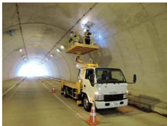
トンネル定期点検
