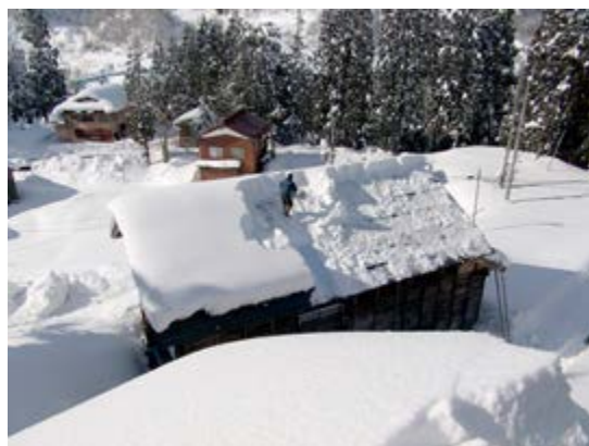
豪雪地域での屋根雪処理
