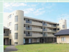
▲公営住宅（北園1号棟）
