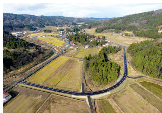
道路の整備(市道18-144号線・山室)
